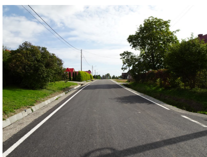
droga 1545K- Stronie
