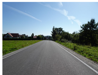
droga 1579K – Przyszowa
