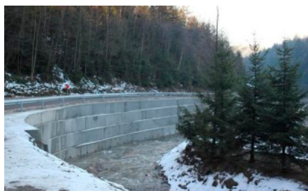
Zabezpieczenie drogi powiatowej w Zalesiu
