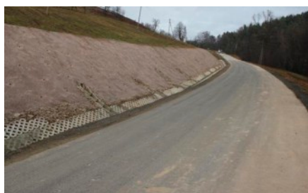
Zabezpieczenie osuwiska w Sechnaj
