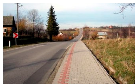
Budowa chodników na terenie gminy Limanowa
