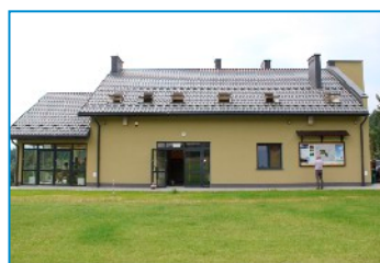
Budynek z salą dla turystów, sanitariatami, pomieszczeniami na ratrak i skuter oraz wypożyczalnia sprzętu.
