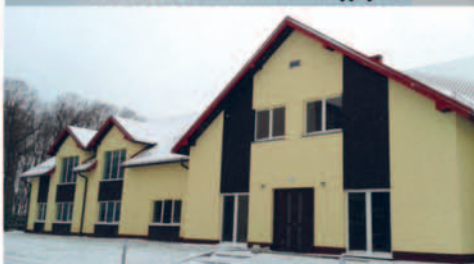
Elewacja budynku i oświetlenie zewnętrzne
