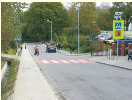
Dzięki modernizacji dróg powiatowych znacznie poprawiło się bezpieczeństwo i komfort jazdy.
