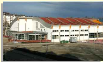
Kryta Pływalnia w Limanowej
