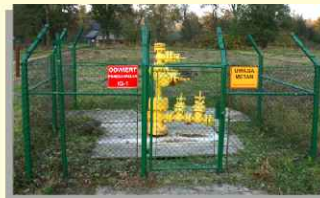
Odwiert wód Geotermalnych w Porębie Wielkiej
