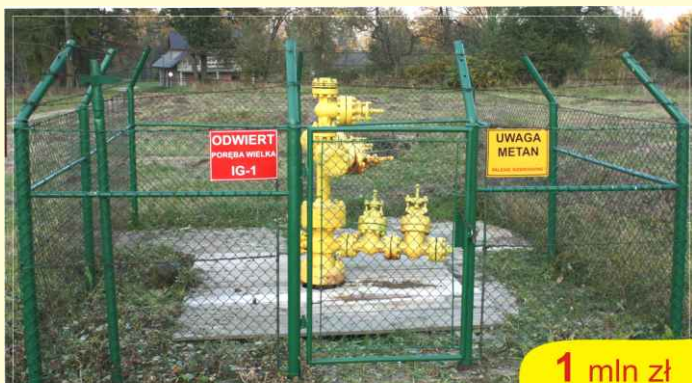
Odwiert wód geotermalnych w Porębie Wielkiej
