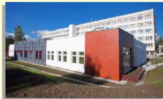
Nowy blok operacyjny w Limanowej
