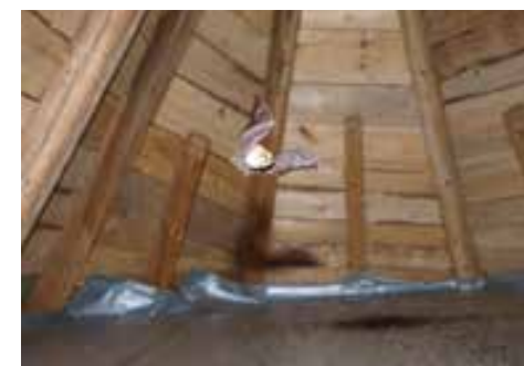
Wyścielona folią paroprzepuszczalną platforma na gówno zabezpiecza obiekt oraz pozwala łatwo sprzątać pozostawione przez nietoperzy odchody
