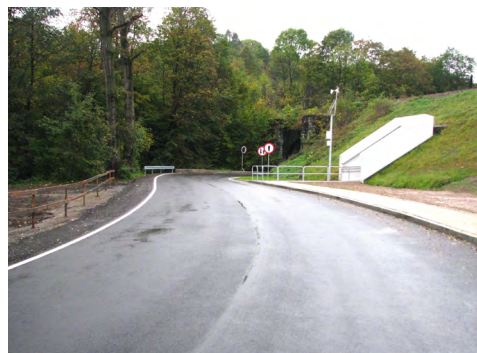
Przebudowa drogi w m. Podłopień
