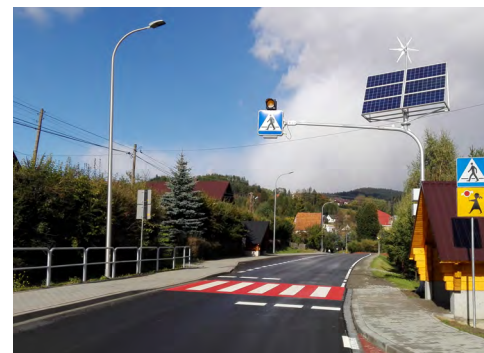
Przebudowa drogi w m. Zalesie
