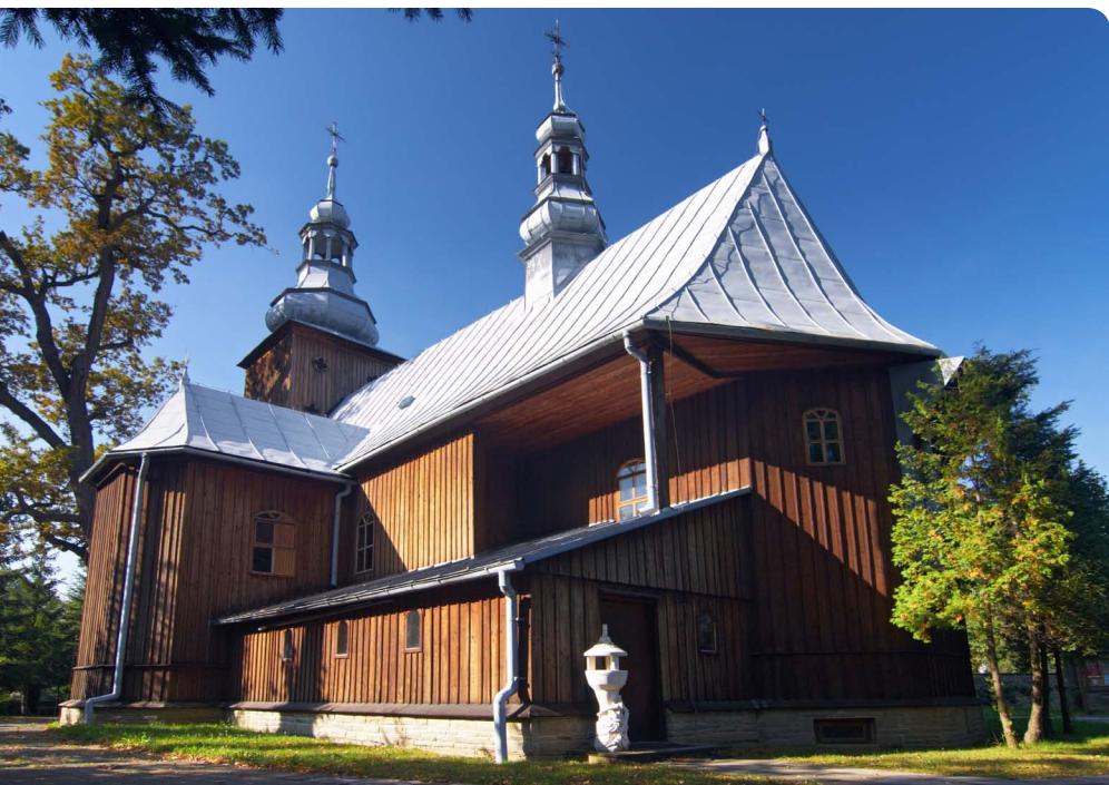
Na Małopolskim Szlaku Architektury Drewnianej..., fot. K. Bańkowski
