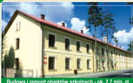
Budowa i remont obiektów szkolnych - ok. 2,7 mln. zł
