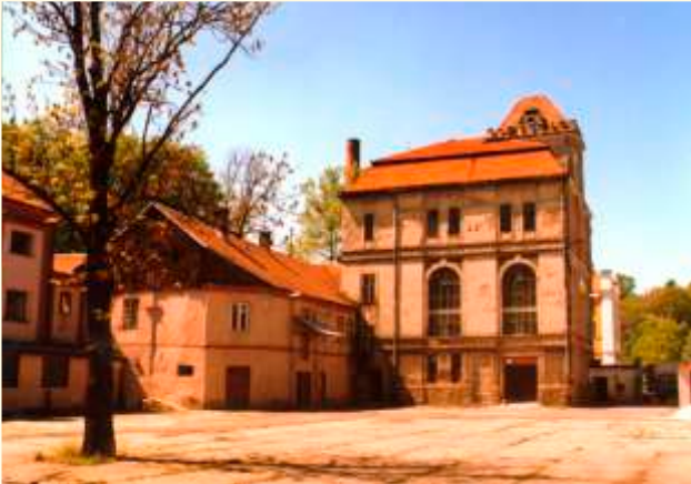
Budynek Centrum Administracyjnego przed renowacją
