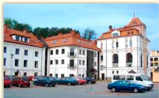
Centrum Administracyjne przy ul. J. Marka 9 w Limanowej
