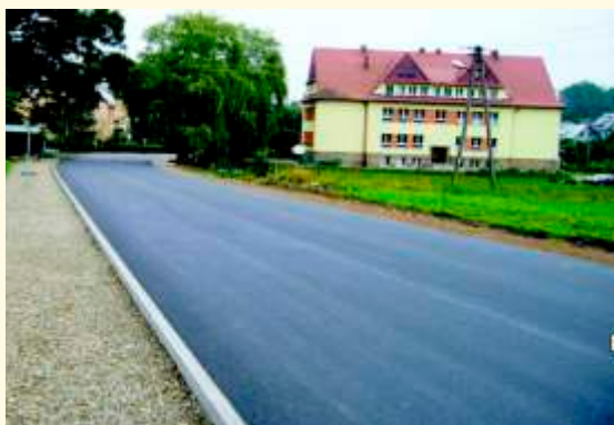
Nowa nawierzchnia asfaltowa - Jodłownik
