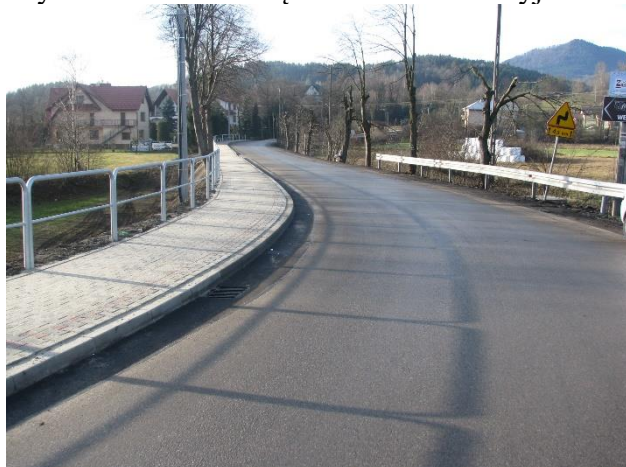
Rysunek 25 Zdjęcie inwestycji pn.: „Przebudowa drogi powiatowej nr 1625K Tenczyn – Glisne – Mszana Dolna w km 8+046,85 – 9+024,75 w m. Mszana Dolna ul. Zarabie –etap I w km 8+640,80 – 9+024,75.”
