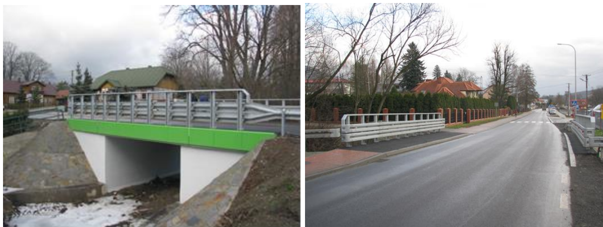
Rysunek 22 Zdjęcia inwestycji pn.: „Przebudowa obiektu mostowego w ciągu drogi powiatowej nr 1551K Limanowa – Chelmiec w km 10+494 w m. Męcina wraz z dojazdami.
