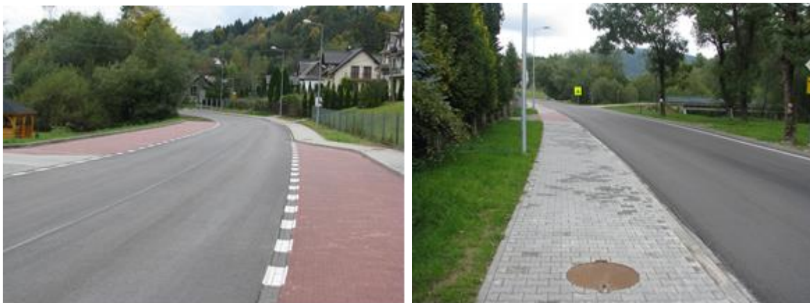
Rysunek 18 Zdjęcia inwestycji pn.: „Przebudowa drogi powiatowej nr 1616K Mszana Górna – Podłopień w km od 2+678 do km 5+085 w miejscowości Łostówka.”
