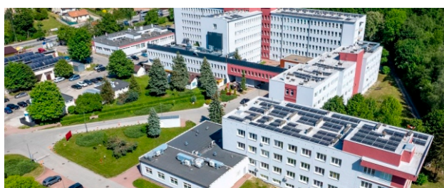
Termomodernizacja Szpitala Powiatowego w Limanowej
