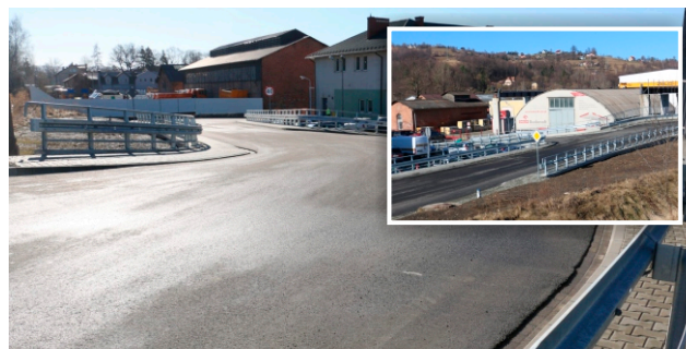
Budowa łącznika do „Strefy Aktywności Gospodarczej”
