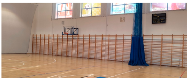
Remont sali gimnastycznej w I LO w Limanowej
