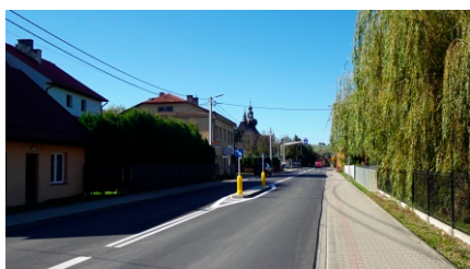
Nowy odcinek drogi w m. Ujanowice
