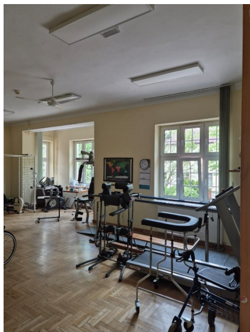
DPS LIMANOWA – malowanie m.in. sali rehabilitacyjnej
