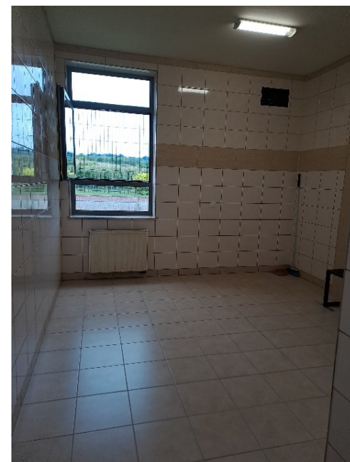
DPS SZCZYRZYK - remont palarni w budynku C
